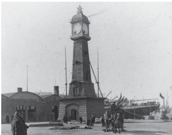
Antic far construït el 1772 i transformat en rellotge el 1911, conegut com Torre del Relloige
